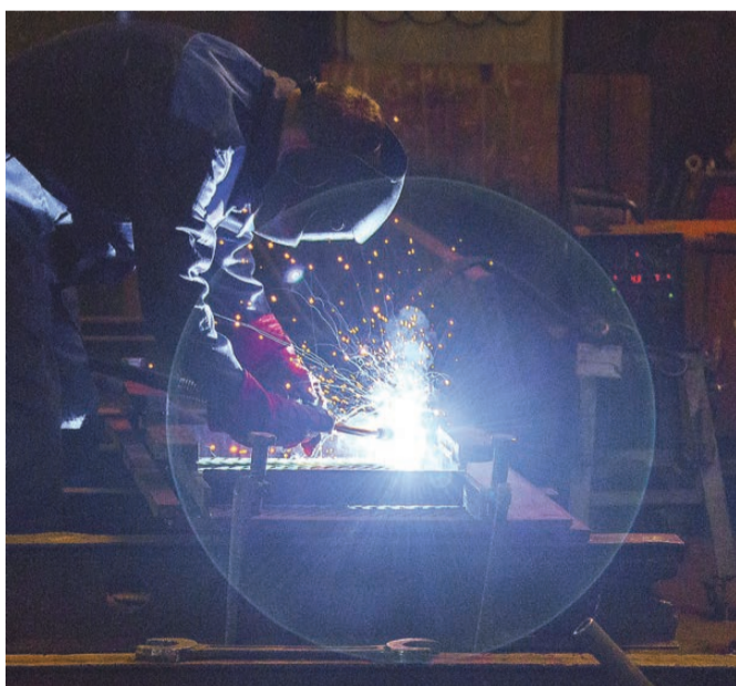
Сварочные работы – дело ответственное.
