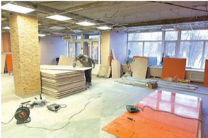
Идет монтаж стеновых панелей.
