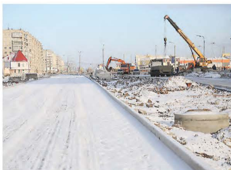
Завершаются работы на сетях, благоустройство территории отложено до следующего года.
