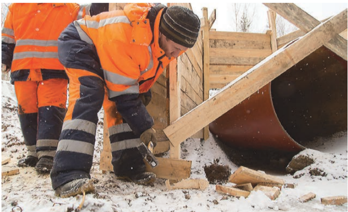
Специалисты УБТ-Сервиса заменили старый водосток, готовят опалубку для бетонирования трубы.
