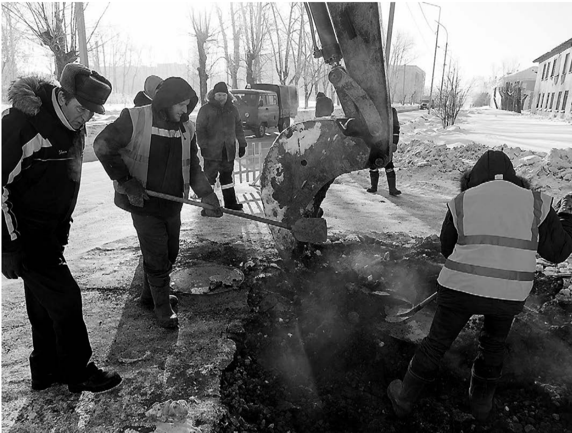
Горэнерго раскапывает аварийную трассу на улице Тимирязева. ФОТО СЕРГЕЯ КАЗАНЦЕВА.
