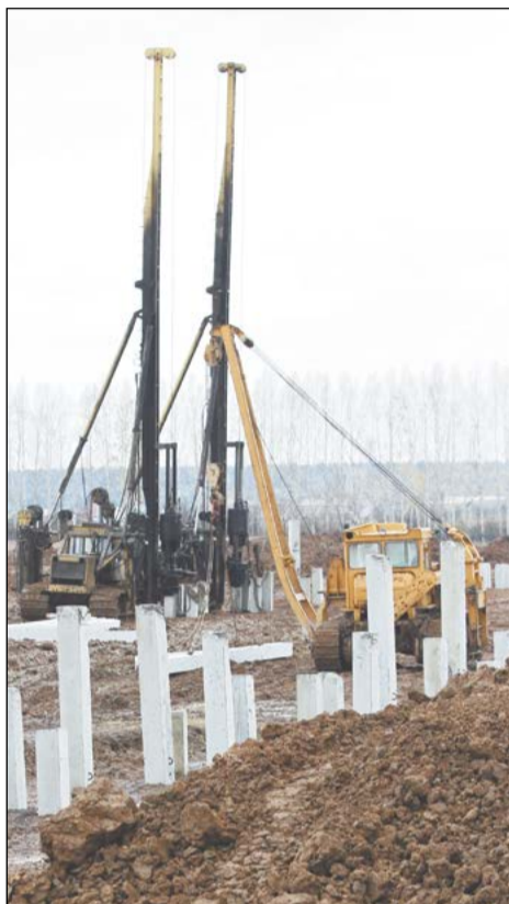
Сваи забивают специальными машинами – сваебойными копрами
