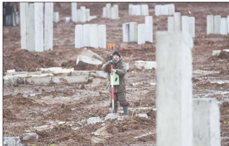
Сваи – основа фундамента будущих корпусов
