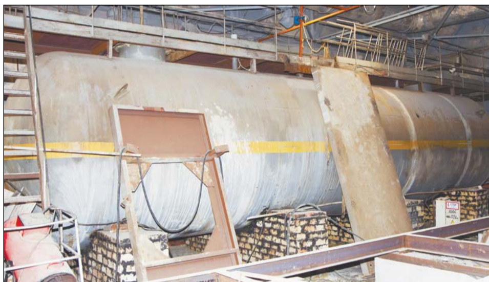
Каждую цистерну с кислотой держат четыре «быка»
