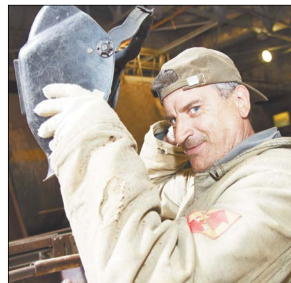
Сварщик «Строительно-монтажного управления» Дмитрий Каштуев завершает обвязку цистерны
