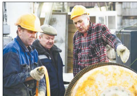
Бетонщики УКСа следят, чтобы новый станок стоял как влитой
