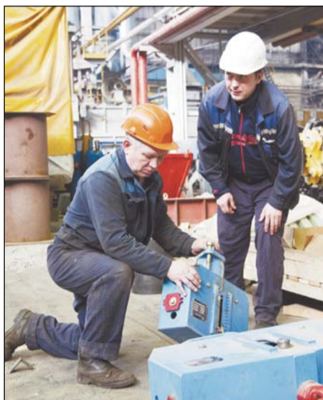
Ещё раз всё проверить перед монтажом
