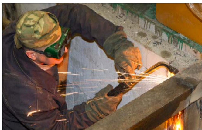
Параллельно с установкой одной из самых важных и мощных составляющих пресса идёт монтаж трубопроводов насосной станции пресса 4 000 тонн
