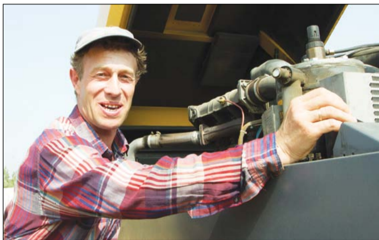
Машинист компрессорной установки Фёдор Венке следит, чтобы аппарат не перегрелся
