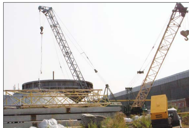
«Тагилстроевцы» собирают кран, который будет необходим для монтажа водонапорной башни
