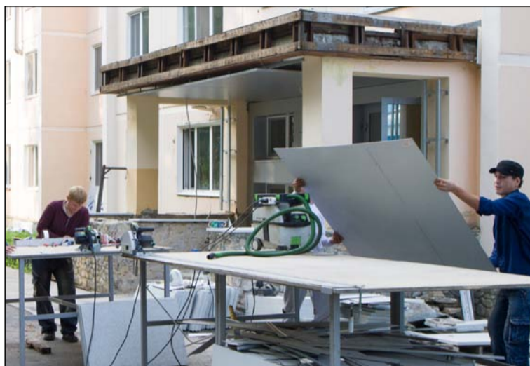
Продолжается реконструкция входной группы медсанчасти
