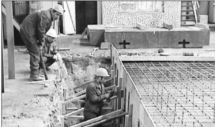
жиниринг» – строят фундамент, для которого был подготовлен полтораметровый котлован размером 8 на 9 метров, произведена его заливка бетоном, общий объём которого составил 90 кубических метров.
