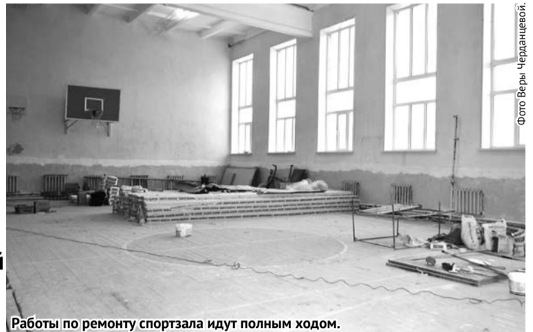
Работы по ремонту спортзала идут полным ходом.
