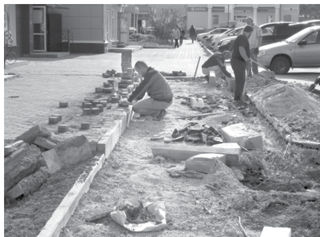
Укладка тротуарной плитки на улице Советской в рамках реализации программы благоустройства.
