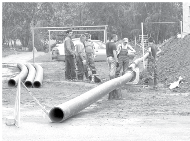
Замена трубопровода в северном микрорайоне.
