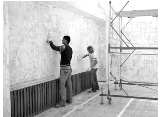
Ремонт спортзала Грязновской школы.
