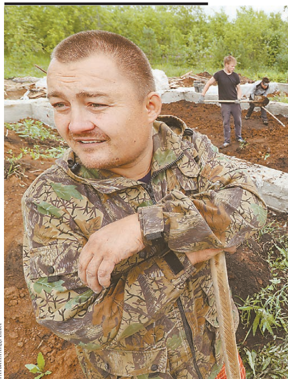
Евгений Мاستриков успел залить фундамент до дождей.
