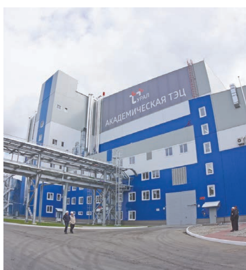
Новая ТЭС «Академическая» в Екатеринбурге оснащена уникальной парогазовой установкой и самым современным оборудованием.
