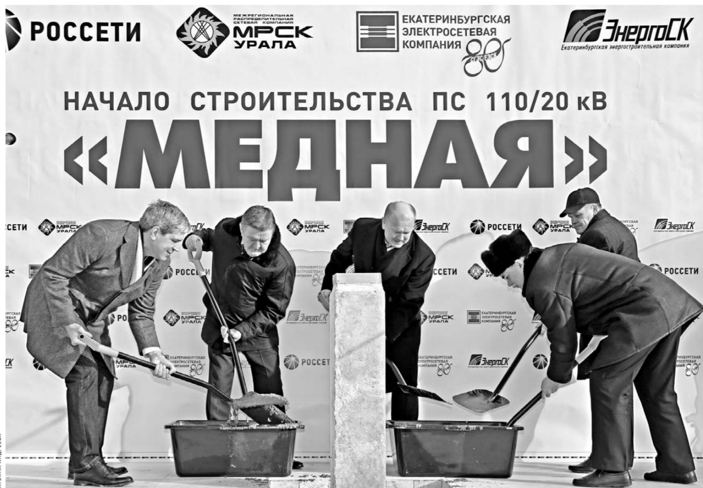
В ОАО «МРСК Урала» дан символический старт строительству первой в Екатеринбурге подстанции напряжением 20 кВ — «Медная». Она повысит надежность электроснабжения потребителей и создаст возможность подключения новых объектов в поселках Широкая речка, Светлореченском, Мичуринском и Медном, а также в микрорайоне Солнечном. По словам гендиректора ОАО «МРСК Урала» Валерия Родина, строительство «Медной» — это начало нового этапа в развитии электроэнергетики. «Мы переходим на новый уровень надежности и повышения эффективности работы в части снижения потерь при передаче электроэнергии», — отметил он. Пуск подстанции «Медная» запланирован на конец текущего года. Объем инвестиций, направленных на строительство и оснащение объекта, составит 232 миллиона рублей.
