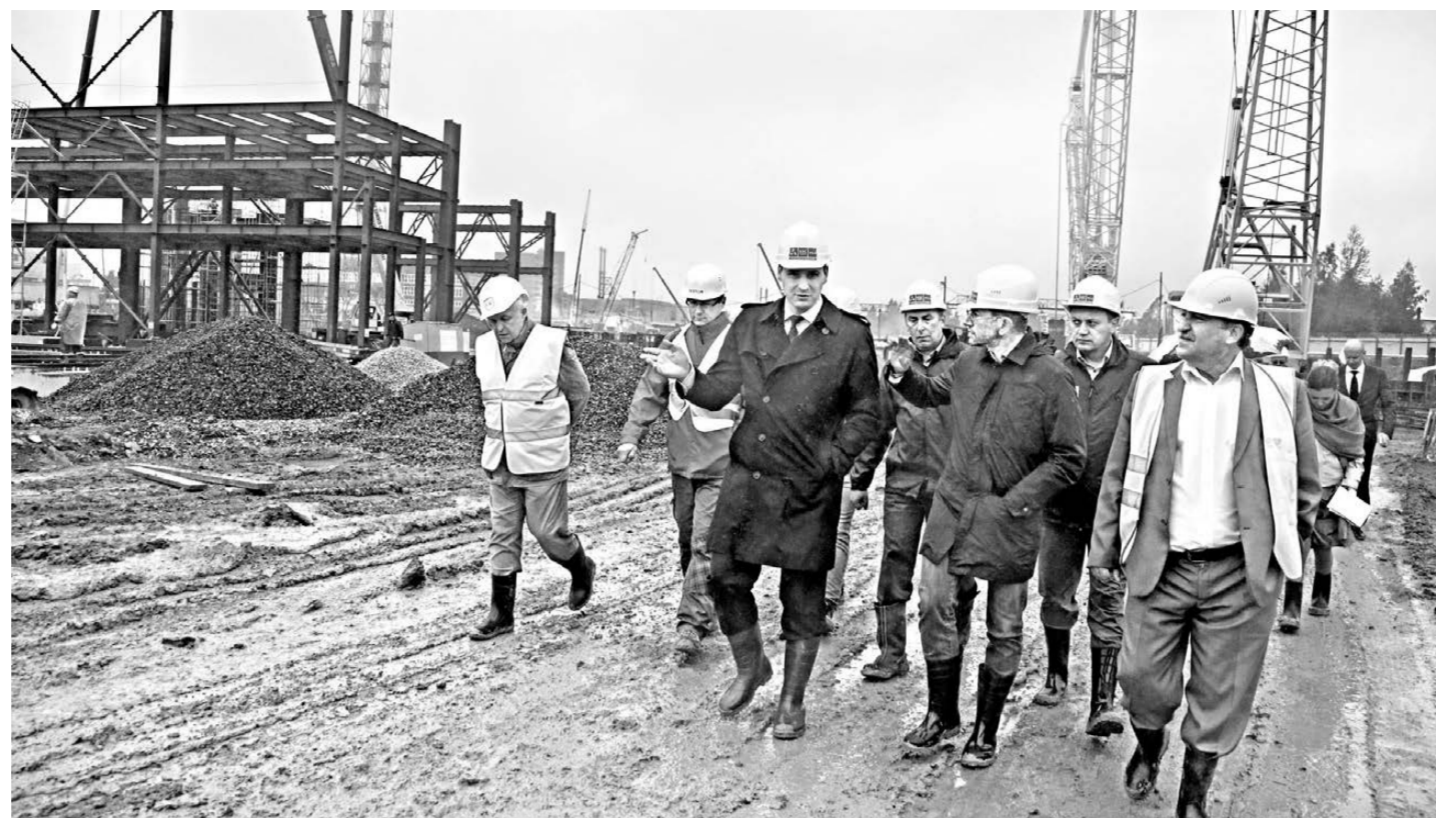
Строительство ТЭЦ «Академическая» в Екатеринбурге перешло в новую стадию: закончены подготовительные работы и началось сооружение фундаментов под каркас главного корпуса. Процесс строительства станции, которая обеспечит развитие юго-западной части мегаполиса, контролирует генеральный директор ЗАО «КЭС» Борис Вайнзихер (второй справа) и председатель правительства Свердловской области Денис Паслер (в центре). Отметим, что возведение современной парогазовой ТЭЦ электрической мощностью 228 МВт и тепловой мощностью 393 Гкал/ч осуществляется в рамках инвестиционного проекта КЭС-Холдинга общей стоимостью 10 миллиардов рублей. Пуск «Академической» запланирован на первый квартал 2016 года.
