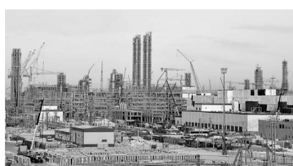
Строительная площадка нефтехимического комбината в Тобольске — самый масштабный объект в УрФО.
