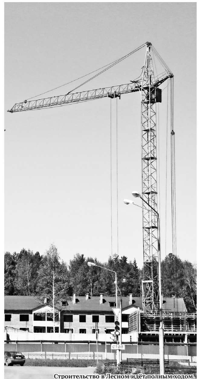
Строительство в Лесном идёт полным ходом.
