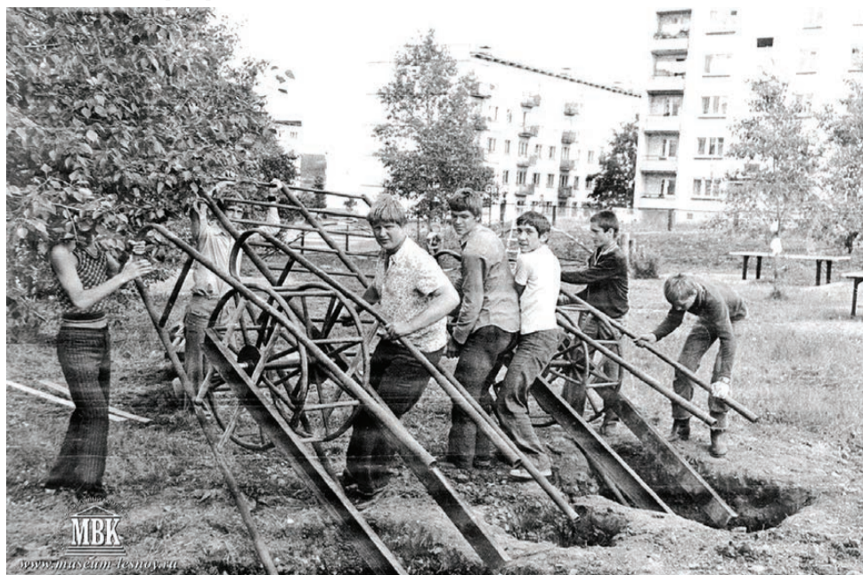
Строительство детского стадиона, бойцы трудового лагеря «Романтик», 1979 г.
