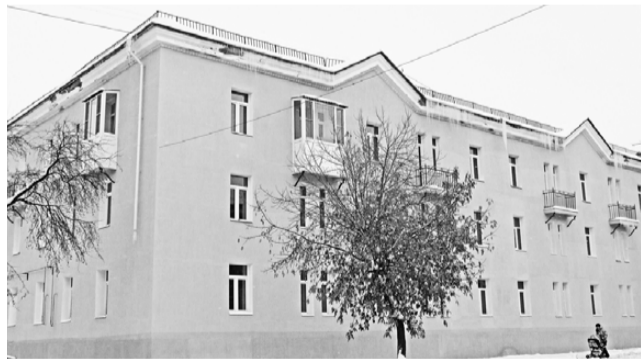
Завершён капремонт дома № 18 по улице Пушкина. Декабрь.
