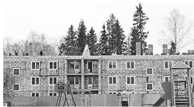
Строительство дома в Чашавите. Октябрь.
