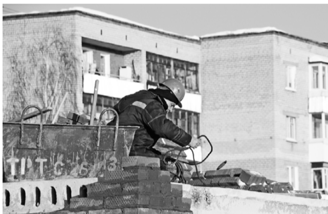
Строительство домов в микрорайоне «Солнечный». Декабрь.
