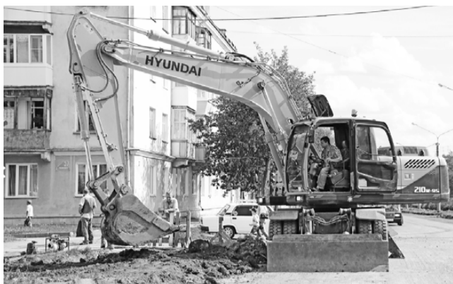
Капитальный ремонт дороги по улице Кирова. Август.
