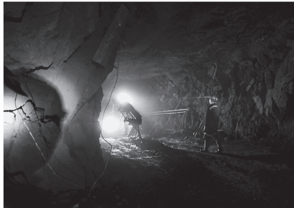
В 2015 году по трём инвестиционным проектам введены в эксплуатацию новые объекты. Это цех холодной прокатки Каменск-Уральского металлургического завода, первый этап строительства шахты «Черемуховская – Глубокая» (на фото) и ангарный комплекс авиационно-технического назначения авиакомпании «Уральские авиалинии».
