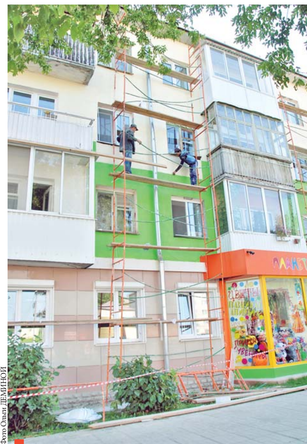
Ремонт фасада дома №5 по ул. Юбилейной
