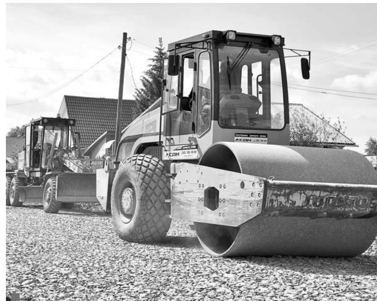
Капитальный ремонт дороги по улице Белинского в Сухом Логу
