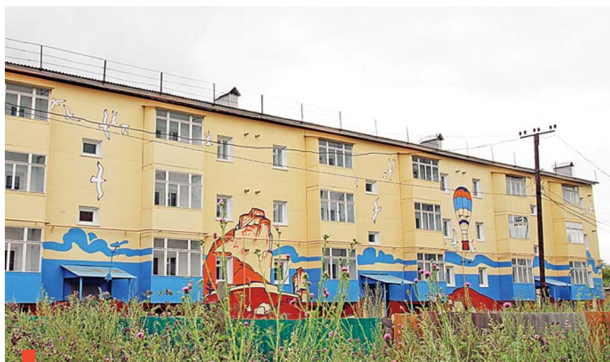
Дом, построенный НП «Знамя», ждет не дожидается новоселов
