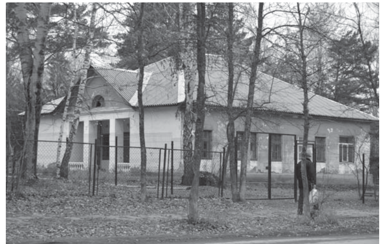
Школа искусств нуждается в ремонте
