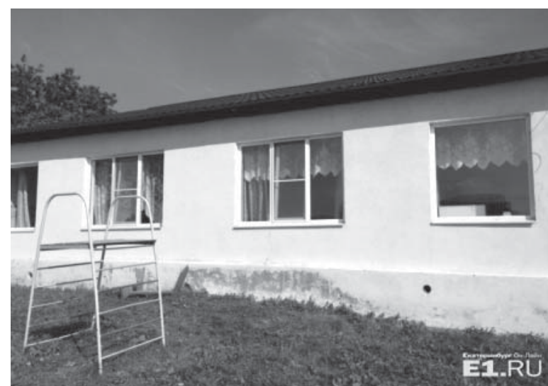
Детский сад после ремонта
