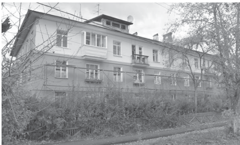
На Орджоникидзе, 8 капитальный ремонт производили в 2017 году
