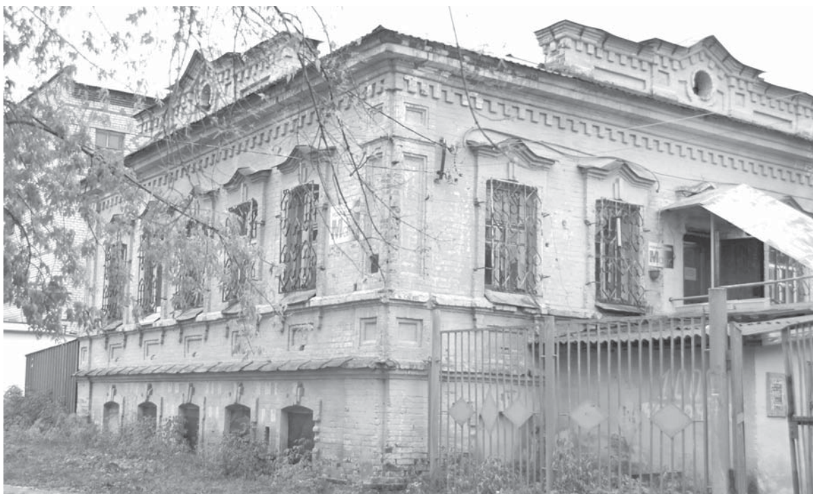
Современный вид исторического особняка. Редакция «Маяка» занимает второй этаж
