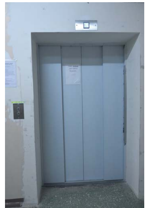
Новый лифт уже в эксплуатации
