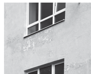
Патруши. Отвалилась фасадная плитка и облупилась штукатурка
