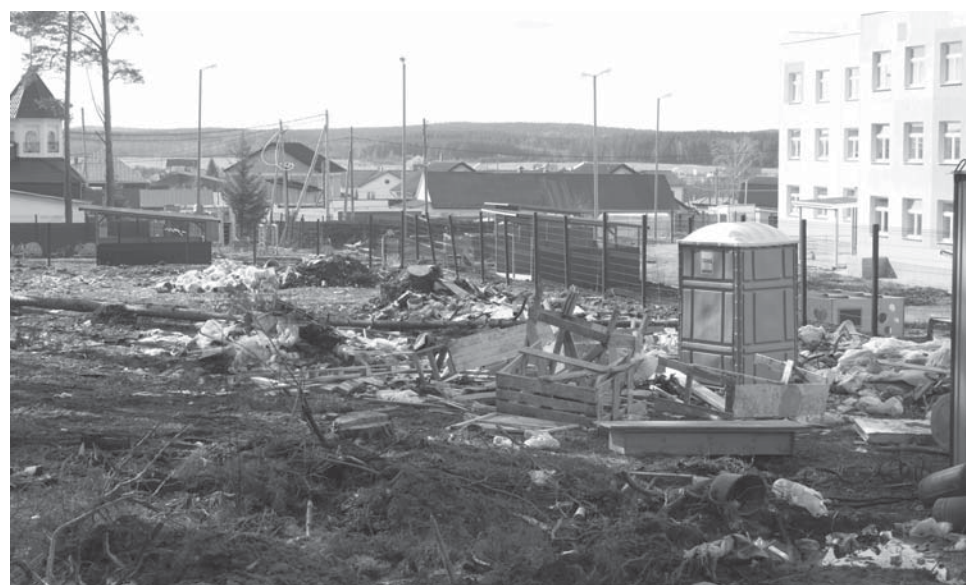
Октябрьский. Свалка строительного мусора и бытовых отходов за территорией детсада
