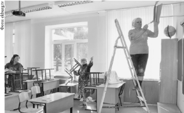
Впереди – ремонт школ.
