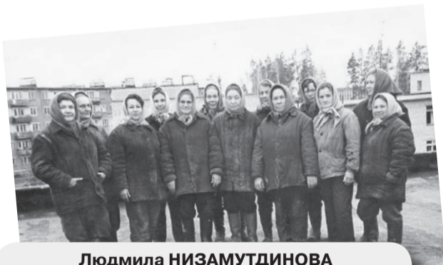
Людмила НИЗАМУТДИНОВА «Бригада кровельщиц на крыше здания роддома»
