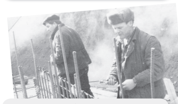
Валентина ШМАТОВА. «Укладка арматуры под блок. На фото Шматов А.А.»
