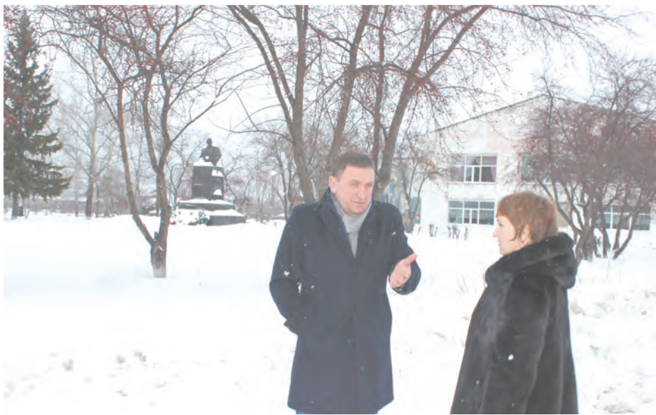
Памятник Н.И. Кузнецову требует ремонта
