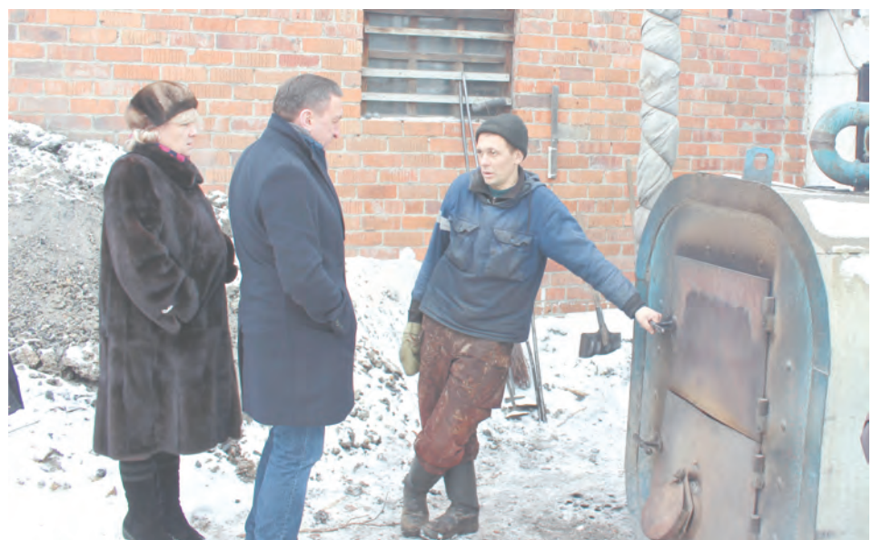
Угля в котельной нет. Котел работает на дровах
