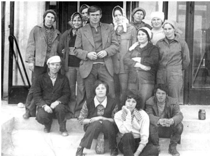
Бригада штукатуров-маляров Н. А. Бундюк, отдавшей стройке 35 лет! В центре снимка – руководитель ПМК-5 Яровиков Анатолий Тимофеевич
