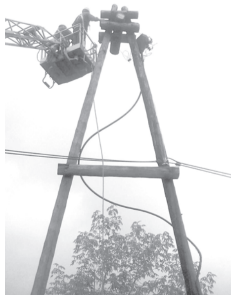
Демонтаж А-образной опоры
