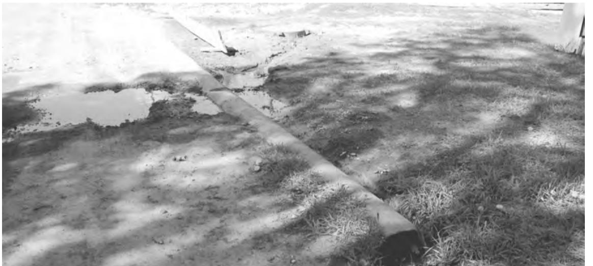
Утечка по ул. Шашмалова в г. Талице.
