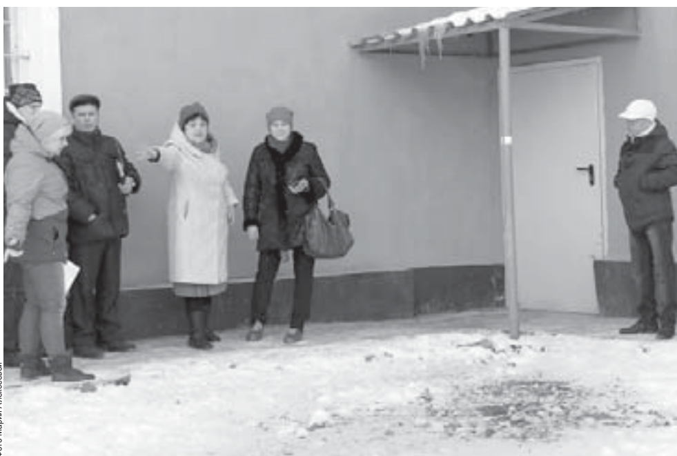
Жильцы дома № 10 по улице Победы рассказывают, что раньше к их подъезду вела нормальная дорожка. Её перекопали, и сейчас люди вынуждены ходить по отсыпке дома – под сосульками
