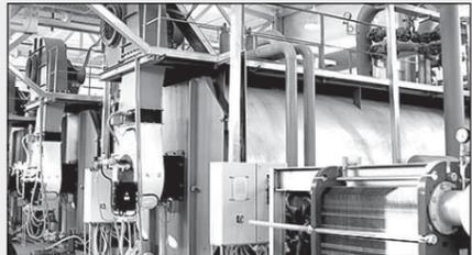
Новая водогрейная котельная с установленной мощностью 60,0 мВт. Она отапливает 462 отдельно стоящих здания, из них 318 – здания жилого фонда, многоэтажное жильё и частная застройка. В качестве основного теплового оборудования использованы пять газовых водогрейных
