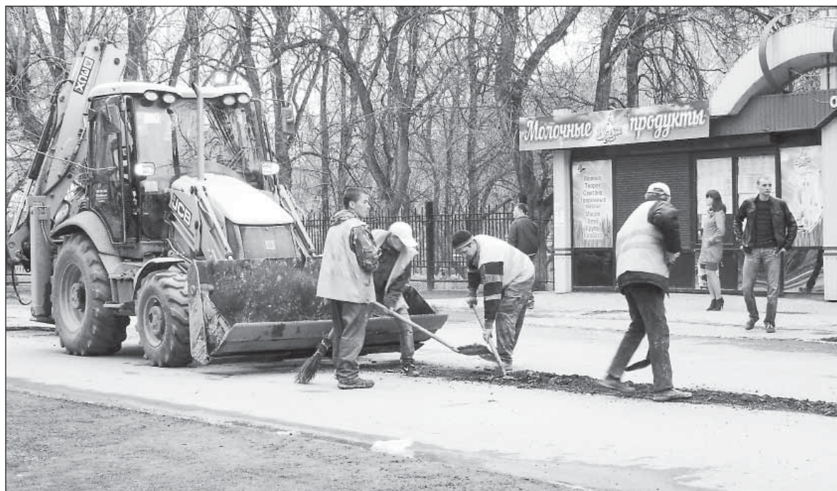
Ямочные ремонты летом будут проводиться на площади 5000 квадратных метров, в обеих частях города
