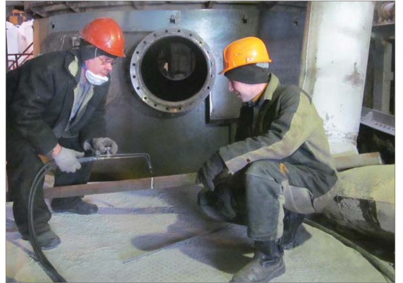
На монтаже печи много работы у сварщиков РСУ Василия Мишкина и Евгения Хромцова.
