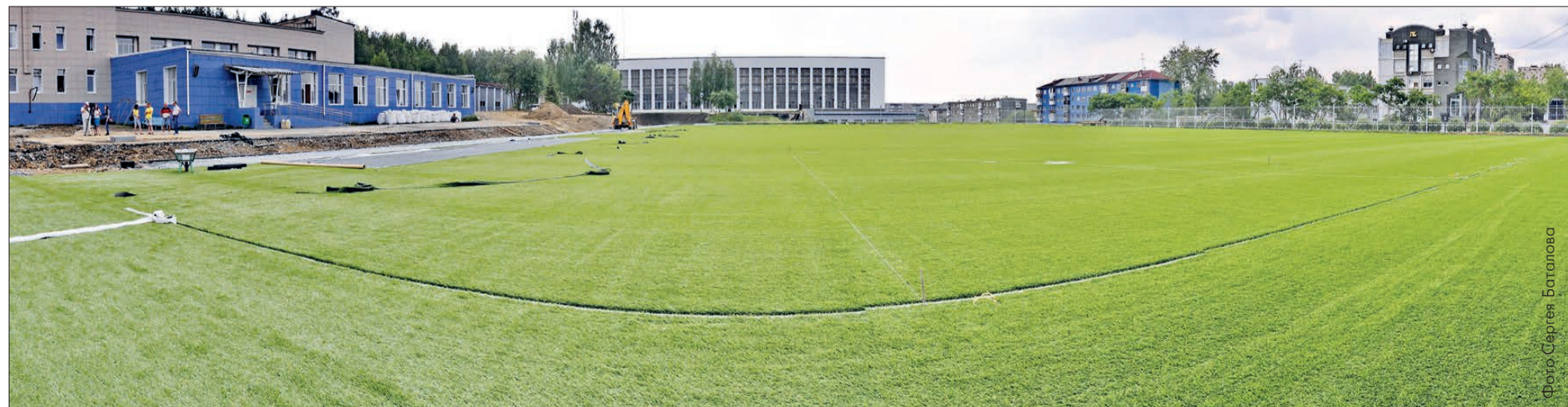
Поле - 100 на 60 м, трава сделана из полиэтилена. Разметка будет выполнена тоже из травы, но белого цвета. Основание футбольного поля – щебеночное
