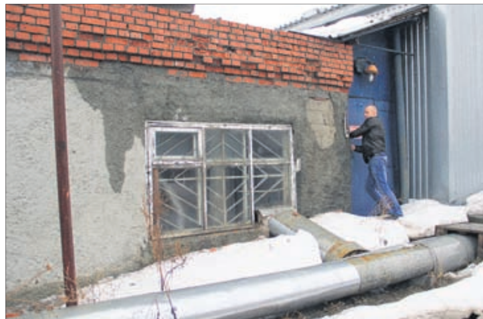
Ремонтировать старые здания котельных — бессмысленно. Проще и дешевле поставить новое модульное здание. Старые котельные закрыты «на ключ».
