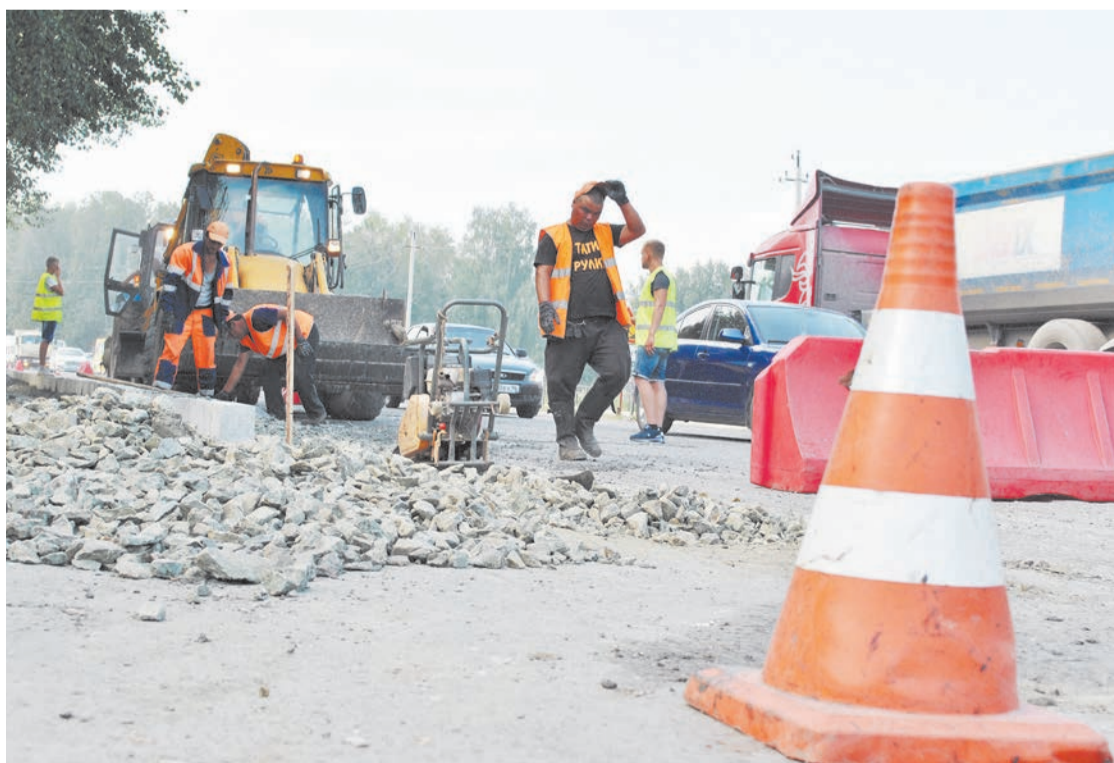
НА СНИМКАХ: идет ремонт участка Березовского тракта
