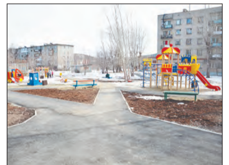
По улице Комсомольской, 12 расширен проезд и благоустроен двор
