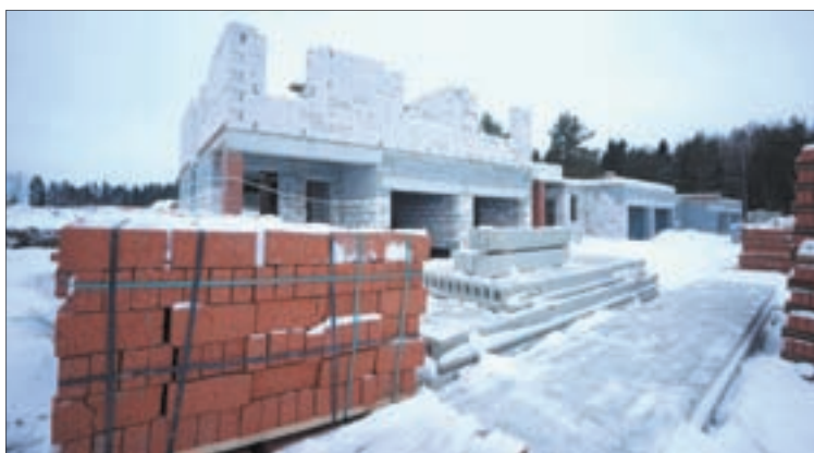
На стройплощадке расположены видеокамеры. Благодаря им, вы можете в он-лайн режиме наблюдать за строительством дома
