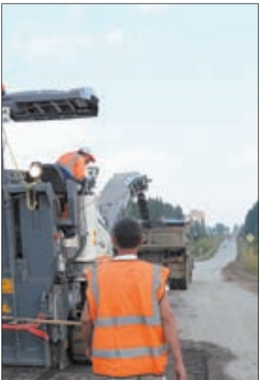
Ремонт дороги на совхоз должен завершиться в этом году.
