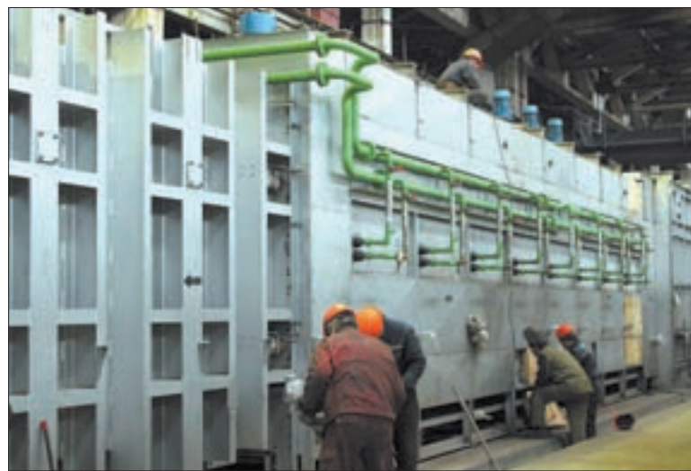
Монтаж печи светлого отжига немецкой фирмы OTTO JUNKER.
