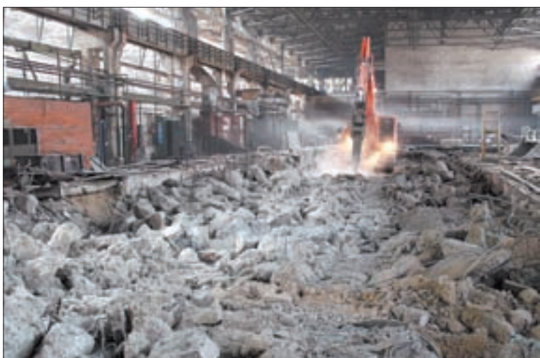
Демонтаж пресса №1 прессово-волочильного цеха.
